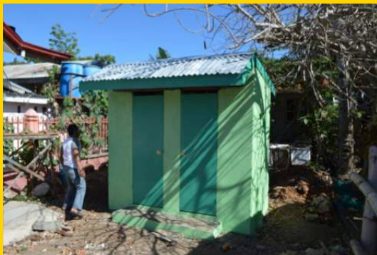
Oxfam bouwde met geld van Giro555 53 gemeenschappelijke toiletten.
